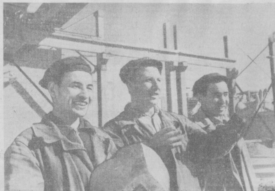
Передовые монтажники стройтреста № 150 Хамид Изотов, Исмаил Сандаметов и Майджид Бурсейтов, работа на строительстве Самаркандского комбината крупнопанельного домостроения, ежедневно перевыполняют свои сменные задания. Фото А. КУЗЬМЕНКО. (Фотохроника УЗТАГ).
