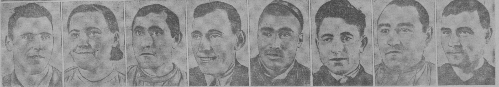
На Чирчикстрое. Вверху: плотина Головного узда. Внизу (слева направо) стахановцы строительства плотины: тт. Г. И. Никитин — старший десятник бетонных работ, К. Ф. Коротаева — десятник подсобных работ, Наби Талиев — бетонщик, В. Н. Малашиков — старший десятник, Мадали Мирвалиев — бетонщик, Г. П. Рынов — арматурщик, Нури Кусанкулов — бетонщик и М. П. Калганов — бригадир бригады арматурщиков. Фото М. Пенсона.
