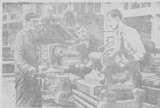
Завод имени Кирова в Тбилиси освоил производство универсальных токарных станков ДИП-300. Сотни таких станков завод должен выпустить в четвертый пятилетке. На снимке (справа налево): начальник сборочного цеха М. Нерозе, стахановец-сборщик И. Бабенко и бригадир Л. Свани у одного из первых выпущенных заводом станков ДИП-300.
