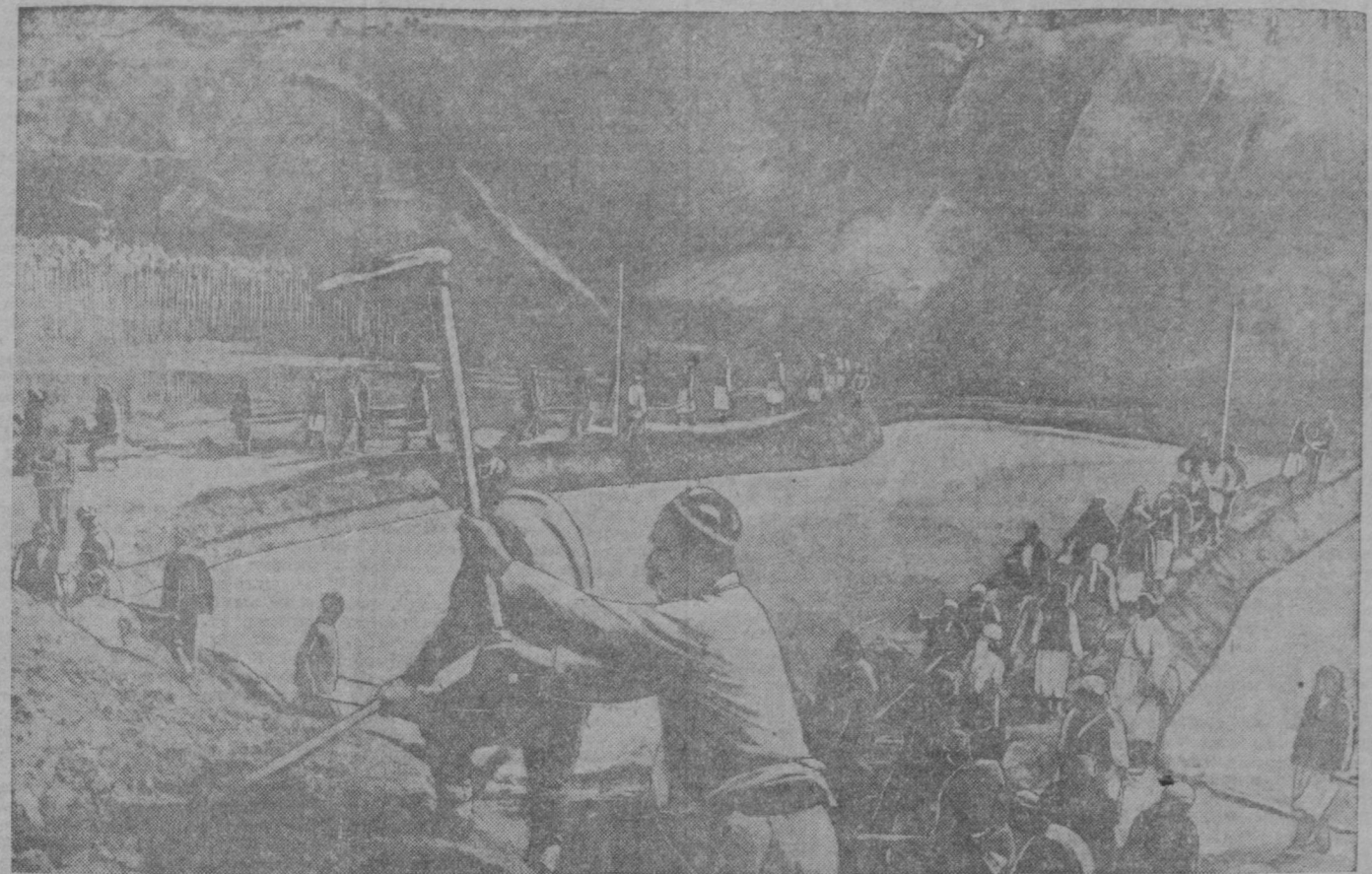
Строительство Бурджарской дамбы Ташкентского канала.
