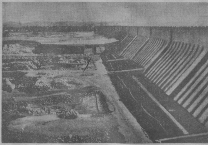
Египет. Часть строящейся Асуанской плотины. Фото агентства Кейстон.
