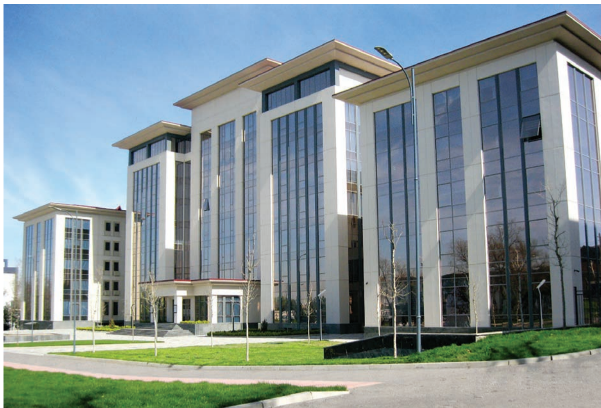
Реконструкция и строительство зданий и сооружений Ташкентского архитектурного института Год строительства: 2022 г. ГАП комплекса: Ташмухамедов Х.Х. Авторская группа: Рахматуллаев Х.А., Имамалиева М.С., Алимбеков А., Махаматханов М. ГИП комплекса: Жарская В.А. ГИП: Мухамадиев А.Ю.,
