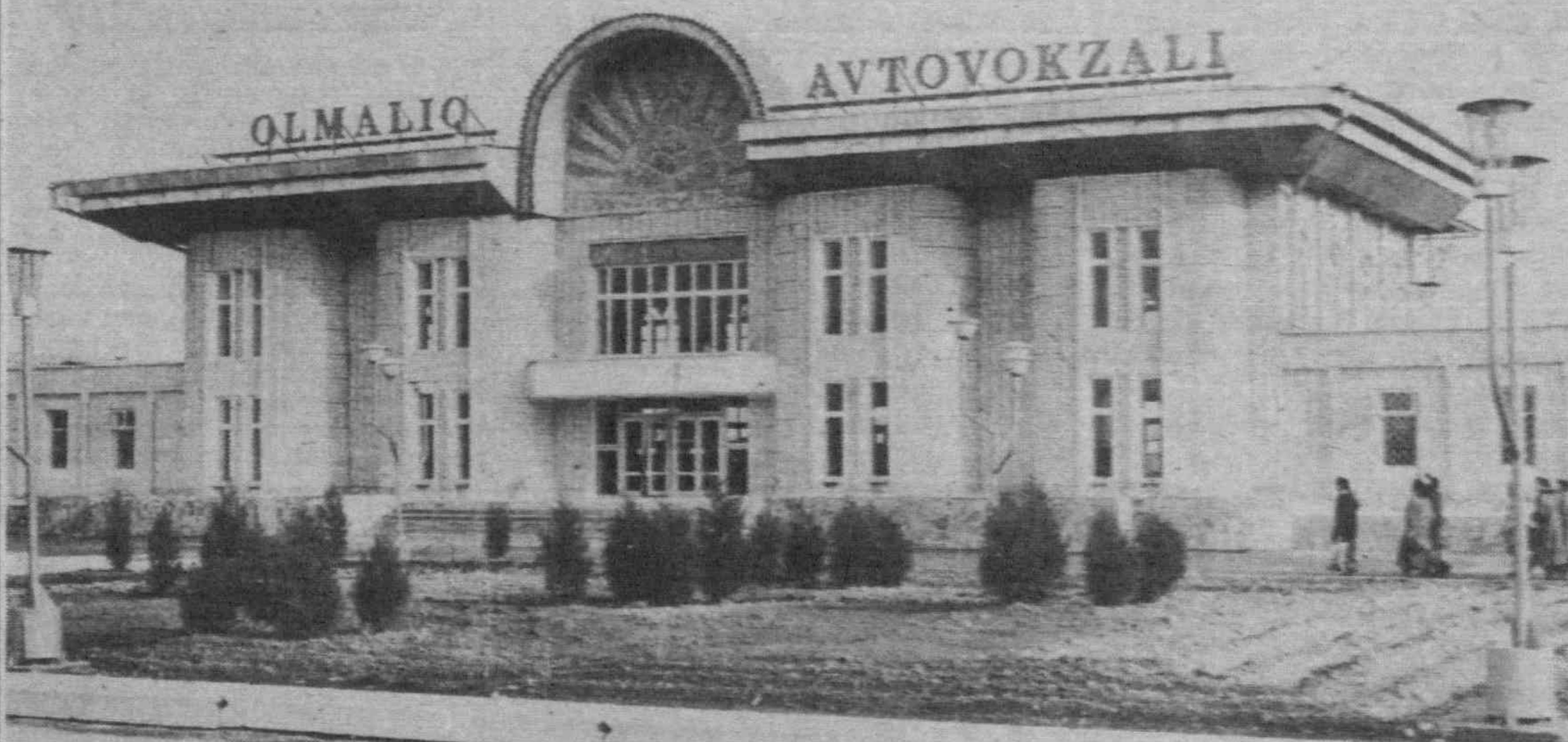
На снимке: здание нового автовокзала в г. Алмалыке.
