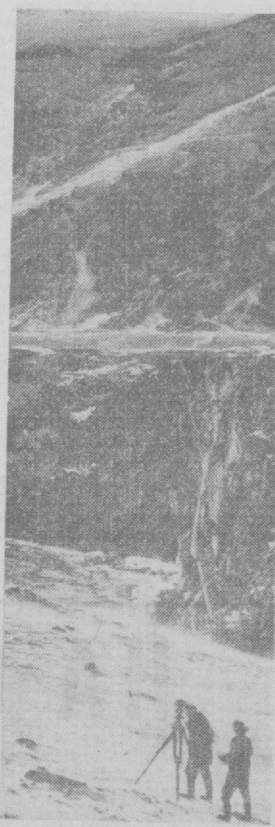
На верхнем снимке справа — экскаватор вымывает первые кубометры грунта на площадке жилого городка строителей ГЭС, в овале — значительный экскаваторщик Н. А. Колбасин. Внизу — на дне будущего Чарвакского моря. Фото авторов и Р. Шамсутдинова. (Фотохроника УЗТАП).
