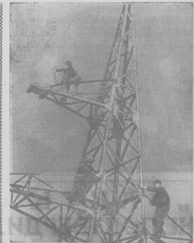
Через пески и болота, через орошаемые земли Каракалпакки, Туркмени и Хорезмской области движется коллектив каракалпакской колонны «Среднеэлектрострой». И там, где строители проходят, одна за другой встают двадцатиметровые опоры высоковольтной электролинии Ташкент-Ургенч. На снимке: монтаж опор высоковольтной линии.
