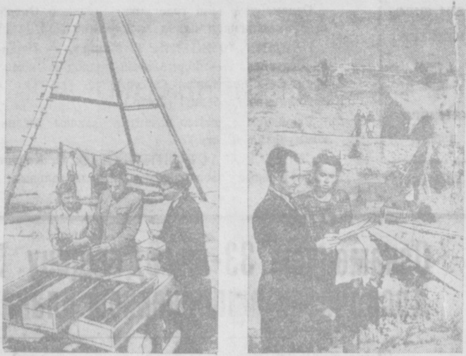
Сталинград. На месте предстоящей стройки Сталинградской гидроэлектростанции развернулись изыскательские работы. Слева: бурение разведочной скважины на месте, где будет бетонная плотина. На переднем плане (справа налево) старший инженер-геолог В. В. Лодочников, начальник инженерно-геологической партии Г. П. Шинягин и коллегия В. И. Ерыгина. Справа: проходила опытная шахта на правом берегу Волги в районе, где будет сооружена плотина. На переднем плане заместитель главного геолога Н. П. Силинов и старший техник-геолог комсомола Е. Н. Страхова. Фото А. Маклецова (Фотохроника ТАСС).
