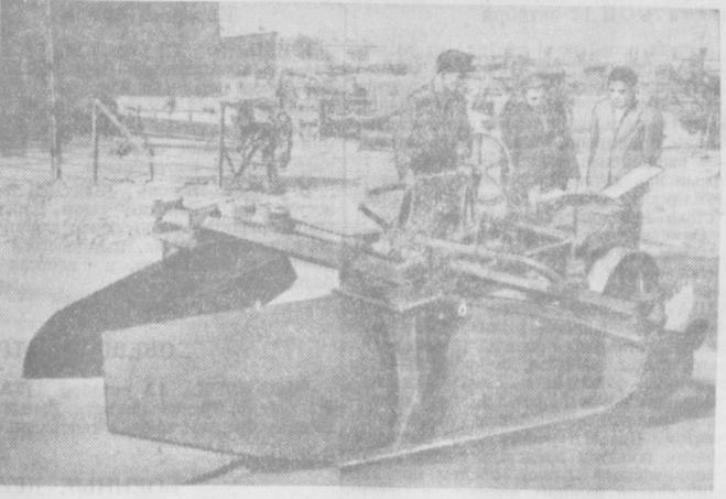
В связи с переходом на новую систему орошения колхозы завода «Чирчиксельмаш» приступают к изготовлению принципиальных схем и специальных инструкций для машинной уборки хлопка. На снимке: слесарь завода «Чирчиксельмаш» А. И. Акулов (слева), главный конструктор Р. С. Фейгин и ведущий инженер-конструктор Х. Ким осматривают опытный образец принципиального канавокопателя и валикообразователя. Фото Б. Мазур. (Фотохроника УзАГ).
