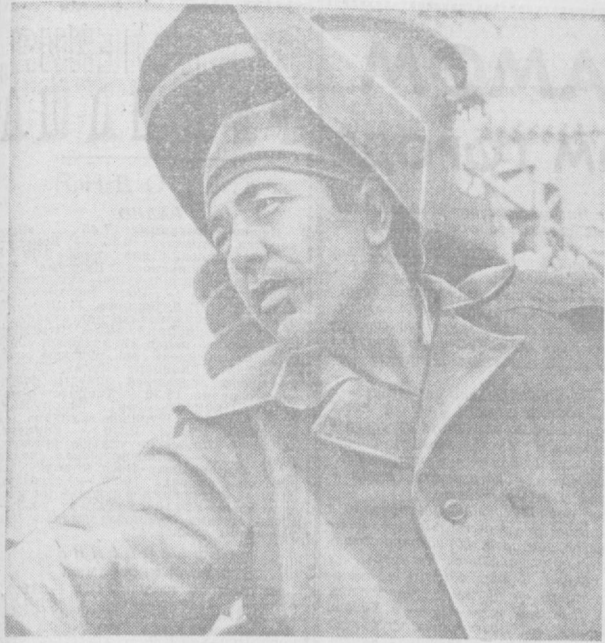
На строительстве Ташкентской ГРЭС отчаянно трудится электросварщик Б. Сатыбалдыев, которого вы видите на этом снимке. Свою норму он систематически перевыполняет. Б. Сатыбалдыев участвовал в строительстве Кайраккумской ГЭС и Анженской ГРЭС.
