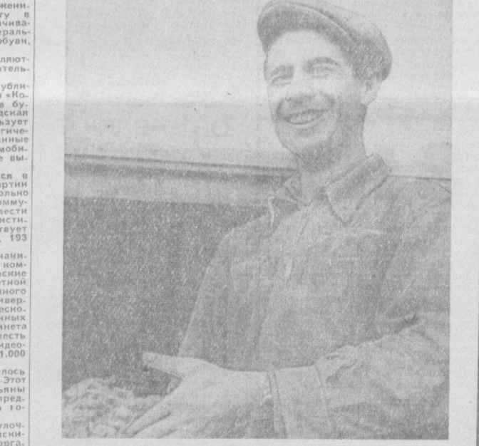
И днем и ночью не умолкает рокот моторов на строительстве Джизакского водохранилища, емкость которого достигнет девятиста миллионов кубометров. С вводом его в эксплуатацию будет орошено более восьми тысяч гектаров новых земель. Коллектив строителей «Джизакводстроя», соревнуясь за достойную встречу Пленума ЦК КПСС, почти в полтора раза перевыполнил десятидневное задание, перебрал более одного миллиона кубометров грунта. Сейчас здесь сооружается плотина длиной в 5,5 километра. Отличных успехов в труде добилась бригада механизаторов депутата Верховного Совета СССР Марка Ташмулатова. На снимке: лучший бульдозерист бригады Илья Коваленко, выполняющий сменные задания на 160—170 процентов. Фото А. Горюхина, (Фотохроника УЗТАП).
