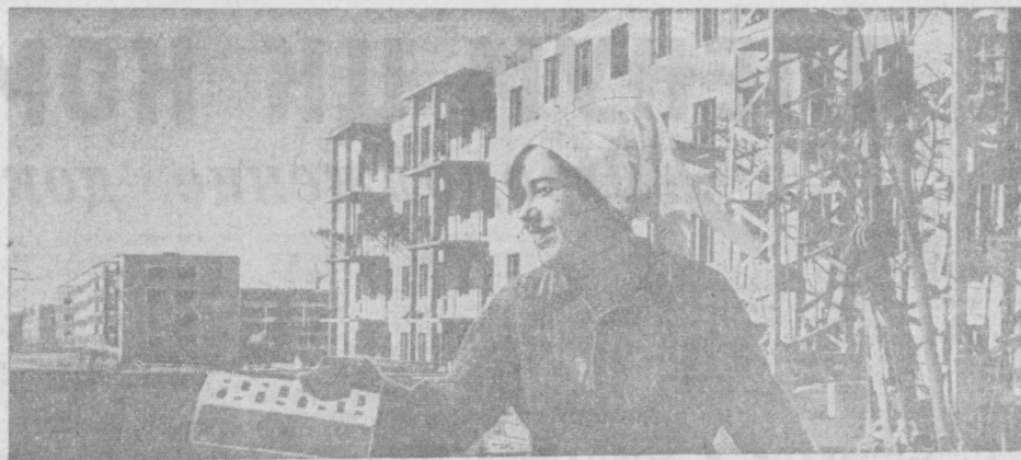
Ленинградские строители сооружают самую широкую в Ташкенте улицу — улицу Горького. На снимке: вид на один из ансамблей улицы. На переднем плане — строитель Галина Андреева из первого строительского отряда. Фото А. ПАЛЕХОВА.
