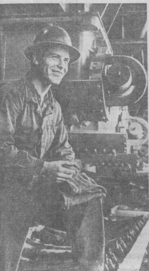
На металлообработочной фабрике Латышополканского полиметаллического комбината имени В. И. Ленина ведется монтаж оборудования сальной секции. С вводом ее в эксплуатацию будет дополнительно перерабатываться несколько сот тонн руды за смену. На монтажных работах отличился сальвар Владимир Кошачев, которого вы видите на этом снимке. Все выполненные им работы получают только высокую оценку.
