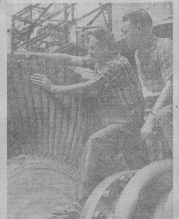
Монтажники и строители Ташкентской ГРЭС высокими темпами ведут строительство и монтаж четвертой турбины. На снимке: руководитель бригады монтажников А. И. Козловский (слева) и начальник монтажной площадки В. К. Цуцарев готовят к установке ротор турбины. Фото В. Сироткина.
