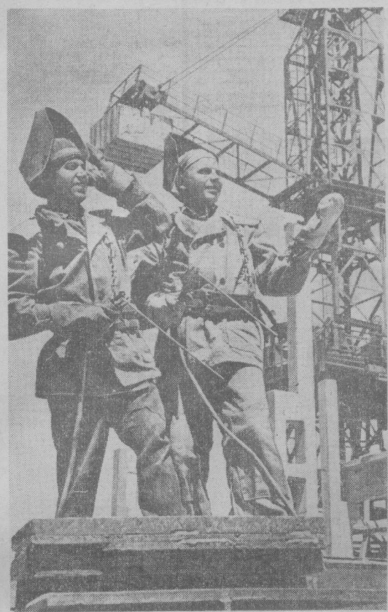
Строители-монтажники треста № 160 Энвер Бекматбеков и Михаил Паладин возводят промышленные корпуса Чирчикского трестформаторного завода. Перевозки рабочих ежедневно выполняют по полторы нормы при отличном качестве работы.
