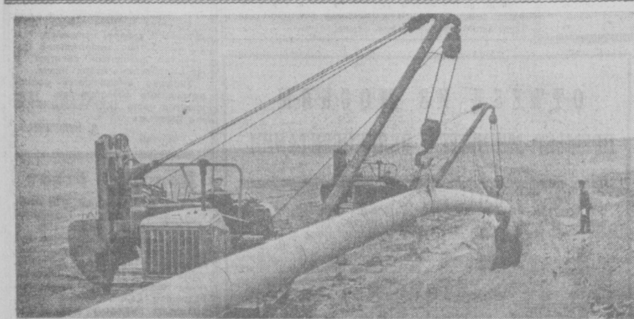
В новой пятилетке будут продолжены работы по освоению Каршинской степи. Этим целям послужит добрую службу строящийся магистральный водовод Пушань-Карши. Уже в нынешнем году он будет подавать 110 литров воды в секунду. На снимке: работы по укладке труб водовода.
