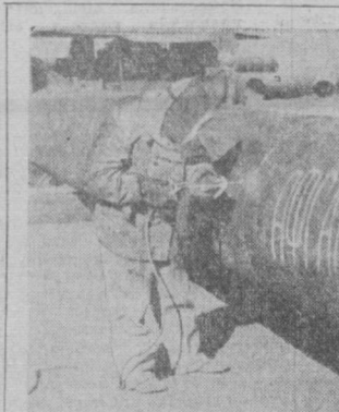
Строители газопровода Афганистан — СССР преодолели самую трудную преграду — реки Анд-Дарью. Через водный рубеж протянут дюкер, и газопровод соединил два берега реки. Еще одна труба, крестовая, протянется между двумя дружественными странами. На снимках: один из участков сварочной площадки; другой — сварщик В. Самойленко.
