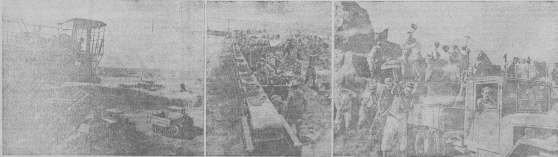
НА КАТТА-КУРГАНСКОМ ВОДОХРАНИЛИЩЕ. 1. Загрузка автомашин с помощью экскаватора. 2. Транспортировка грунта на плотину. 3. Разработка грунта на участке Бухарской области.
