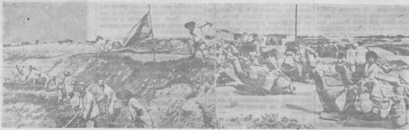
НА СТРОИТЕЛЬСТВЕ ЖЕЛЕЗНОДОРОЖНОЙ МАГИСТРАЛИ ЧАРДЖОУ — КУНГРАД. 1. Колхозники-строители на отсыпке трассы. 2. Караван верблюдов, доставляющий воду строителям. Фото И. Глаубермана.
