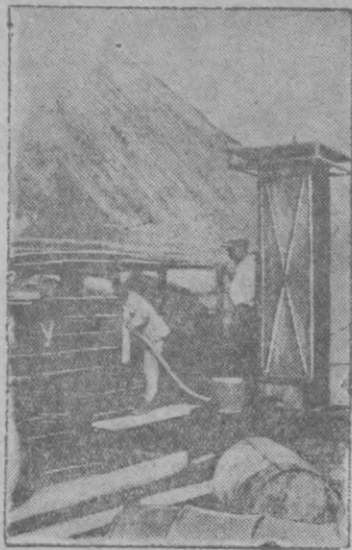
С каждым годом увеличивается дорожное хозяйство на Намангане. Там, где раньше не было дорог, теперь появляются дороги. На снимке: заправка авто машины у бензоколонки на высоте 2,600 метров.
