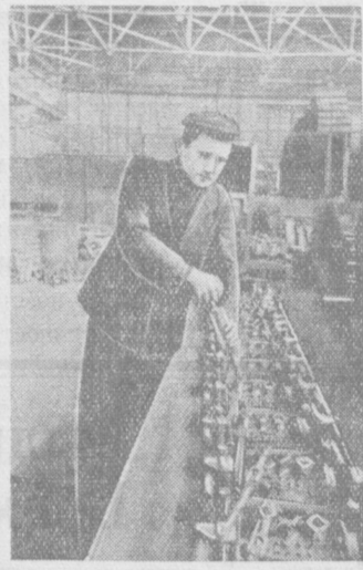
Коллектив завода «Ташсельмаш» имени Ворошилова приступил к изготовлению деталей — узлоузелителей «СН-42» для новой модели «СНП-4». Первым партией узлоузелителей «СН-42» уже сделана для сборки новой модели. На снимке: слесари-сборщик В. Удогович проводит смазку новых деталей. (Фотохроника УзТАГ).
