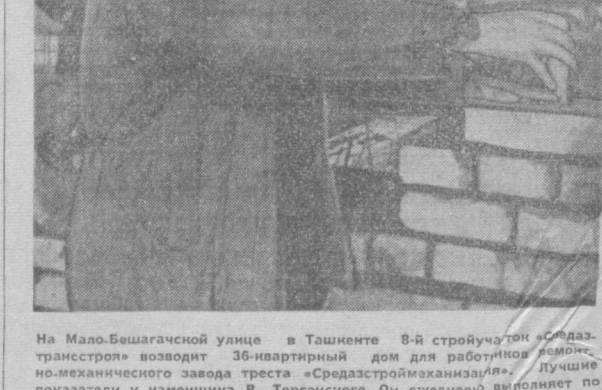
На Мало-Бешагаской улице в Ташкенте 8-й стройучасток «Средзастрон» возводит 36-квартирный дом для работников ремонтно-механического завода треста «Средзастронхиманализ». Лучшие показатели у наемника В. Торгонского. Он ежедневно выполняет по полторы нормы. НА СНИМКЕ: В. Торгонский за работой. Фото М. Комлева.
