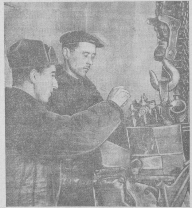
В Ходинабадской РТС Андриановской области идет подготовка техники и в поле. Коллектив РТС решил закончить ремонт ее к 20 февраля. НА СНИМКЕ: механик РТС И. Ф. Лукьянов и слесарь-монтажник С. Кутлибаев проверяют двигатель. Фото С. Безносова.
