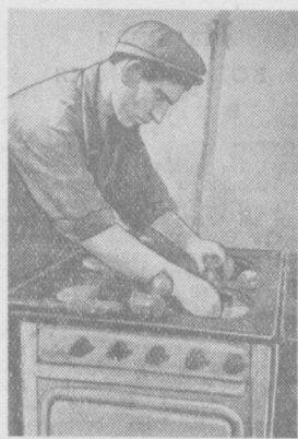
В жилых домах на Чиланзаре (Ташкент) прокладываются газовые трубы и в квартирах устанавливаются газовые плиты. НА СНИМКЕ: слесарь А. Равдин устанавливает газовую плиту в кухне нового жилого дома. Фото М. Турсунджоева и К. Рашидова. (Фототехника УЗТАП).
