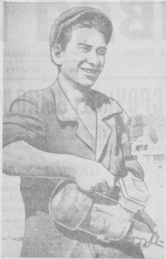
Монтажник Петр Рагозин, работая на сборке крупнопанельных жилых домов на Ан-Тепинском жилом массиве (Ташкент), ежемесячно выполняет производственное задание на 150 процентов.
