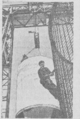
НА СНИМКЕ: монтажники комсомолец Михаил Шарпов обвязывали арматуру облоком для одной из опор моста. Фото Е. Соколова. (Фотохроника ТАСС).
