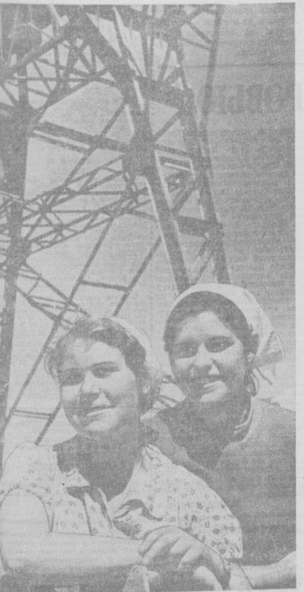
С первого дня начала работ на крупнейшую стройку семилетки — Ахангаранский цементный завод пришли подруги Токт. Крайчук и Галия Шакаримова, которых вы видите на снимке. Две нормы за смену — стали квалификационными бетонщицами. Две нормы за смену — таковы их производственные показатели. Фото И. Глауберсона и В. Сироткина.
