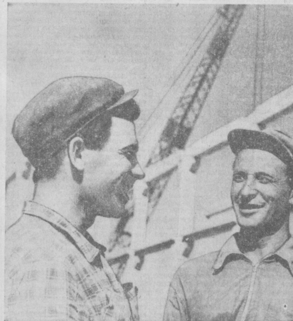
На строительстве Ташкентской ГРЭС мастерски работает бригада, возглавляемая Виктором Хахановым. Каждый член этого передового коллектива освоил по две — три специальности...
