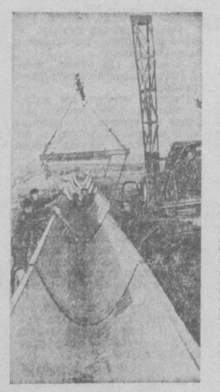
Лоток к лотку — и новый искусственный канал готов. Живительная влага потечет по нему, даст жизнь пустынным землям.
