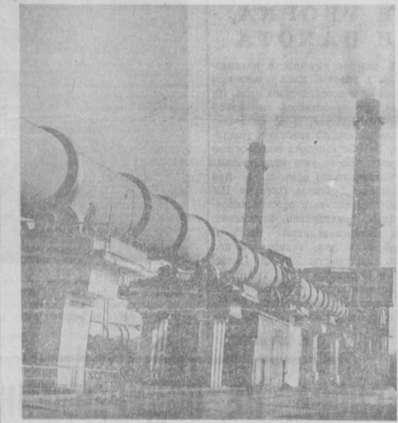
На Беговатском цементном комбинате сдана в эксплуатацию вторая агрегатная печь, которую вы видите на снимке. Ее производительность 220 тысяч тонн цемента в год. Теперь предприятие будет выпускать ежегодно до шестисот тысяч тонн цемента.
