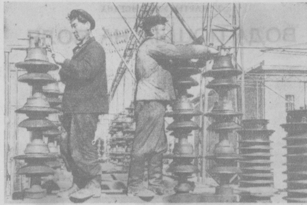
В Карасуйском районе Ташкентской области завершаются предпусковые работы на крупнейшей в республике Куйлюкской электростанции, которая подключится к линии Кайрак-Кумской ГЭС. На снимке: электромонтер Х. Низанбетов (слева) и В. Кириллов регулируют аппаратуру подстанции. Фото Г. Пуна. (Фотохроника УзТАГ).
