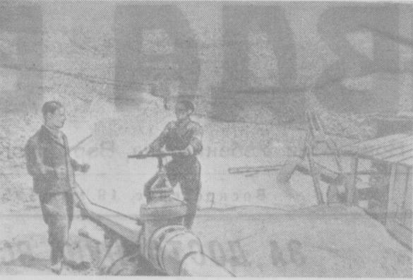
АНГРЕЙ. На Ангренском угольном разрезе в нынешнем году на вскрыших работах широко применяется гидромеханизация. Теперь породу, там где это возможно, вскрывают не экскаваторами, а гидромоторами. Размытая сильной струей вода порода попадает в землесосные установки и отсыпается по трубам в отвалы. Этот способ работ экономичен и более производителен. Сейчас гидромеханизаторы за смену вскрывают около 7 тысяч кубометров грунта вместо 4800.
