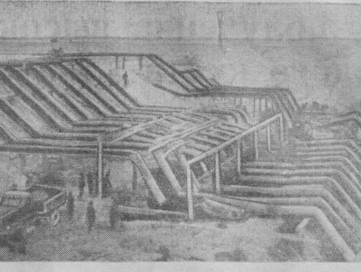
Для орошения целинных земель, расположенных выше уровня оросительных каналов, в Голдной степи сооружаются водонасосные станции. На снимке: строительство водонасосной станции.
