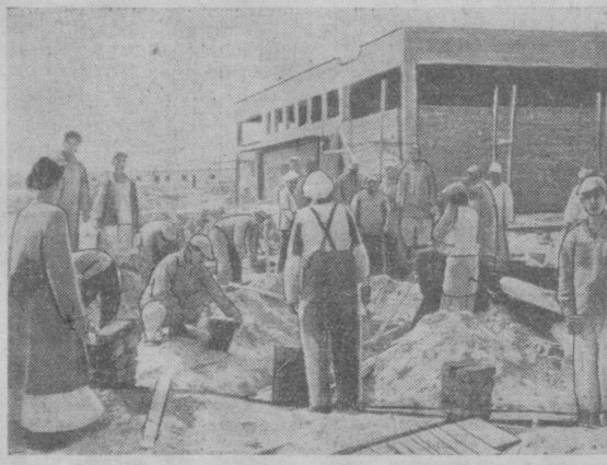
Египет. Ат-Тахир — самая молодая провинция страны. В пустынях возведены благоустроенные деревни нового типа. Возникают новые предприятия, культурно-бытовые учреждения. На снимке: строительные работы.
