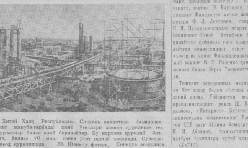
Хитой Халқ Республикаси. Сичуань вилоятида (мамлакатнинг жанубий-ғарбида) кимё ўнгилари заводи қурилиши тез сурыатлар билан олиб бориляпти. Бу корхона қурилиб битгач, йилга 70 миң тонна ўгит ишлаб чиқаради. Суратга завод қурилишида. Ю. Юань гу фотоси, Синьхуа агентлиги.
