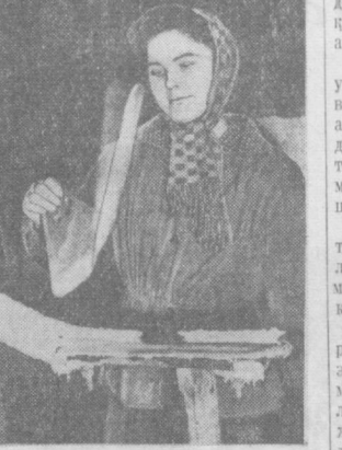
Сурагда: Нина Иванова детални юқори частотали ток ёрдамида тобламоқда.
