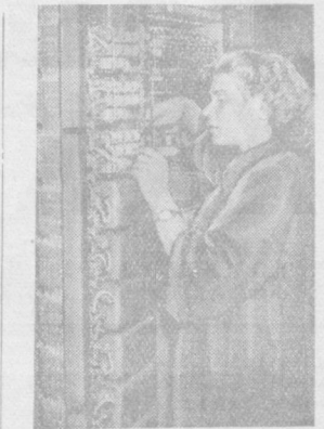
Тошкент шаҳар Фрунзе районода иштироқ авиомат телефон станциясини монтаж қилиш ишлари тугаланишда. Станция шу йилнинг охирида ишга туширилади. Бу ерда аппаратларни ўратгани ва монтаж қилиш ишларини Москвадаги «Союзтелестрой» трестидан келган бригада аъзолари олиб бормоқдалар. Сурата: монтажчилар бригадасининг бошлиғи П. М. Иванова иш устида. (СаТАГ фотохроникаси).
