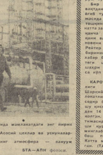
БОЛГАРИЯ ХАЛҚ РЕСПУБЛИКАСИ. Плевен шаҳри яқинида мамлакатдаги энг йирик корхоналардан бири — нефть-химия комбинати курилмоқда. Асосий цехлар ва ускуналарнинг кўпгина қисми ўрнатиб бўлинди. Суратда: комбинатнинг атмосфера — вакуум курилмаси.
