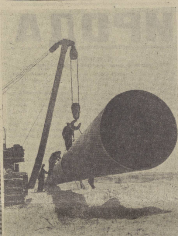
«Нефтепроводмонтаж» трестига қарашли 2-қурилиш бошқармасининг монтажчилари Ўрта Осиё — Марказ газ қувурининг 3-навбат қурилишида қатнашиб ишда вазт ичиди анчагина масофадаги раёвандлаш ва изоляциялаш ишларини тамомладилар. Суратда: Ўрта Осиё — Марказ газпро-водининг 3-навбат қурилиш участкаларидан бирида.
