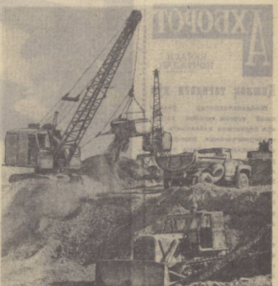
Сурхондарь области. Узунлиги 54 километрли, биринчи навбатдан секундига 20 куб метр сув ўтадиган «Амударь-Занг» канални қурилиши тез сурушлар билан давом эттирилмоқда. Дарё ўзига барпо этилаётган иккинчи станцияси Амударь сувининг 85.90 метр баландга қўтариб беради. Сурашларда: (юқоридан пастга) 1. Ўзасос станцияси ниқилишида тулпоқ ишлари бажарилади. 2. Илғор қурилиш участкасининг раҳбари инженер Хушбон Шамуродов. В. Лейзерович фотолари (ЎзТАГ фотохроникаси).
