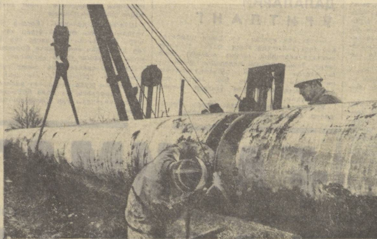
Германия Демократик Республикасида 250 километрик газ қузурини ётқириш ишлари бошлаб юборилди. Бу қузувр Совет Иттифоқи, СССР ва ГДР орқали ўтувчи газ
