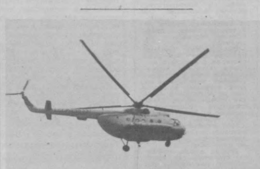
НА СНИМКЕ: вертолет подает плиты покрытый для укладки на одном из реконструируемых цехов.
