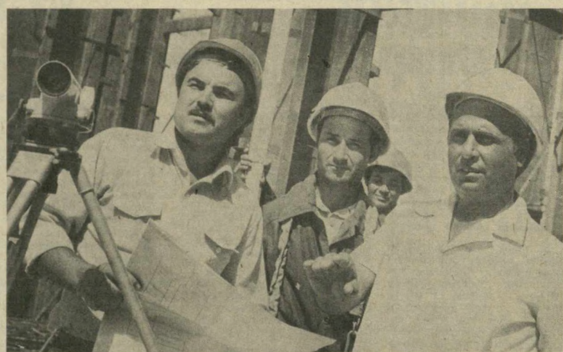
Значительно расширил фронт наступления на целиннику Каршинской степи уникальное гидротехническое сооружение на пересечении двух крупных водных артерий — Каршинского магистрального канала и реки Кашкадарья. Строительство не имеющего аналогов в Средней Азии железобетонного донора вел-
