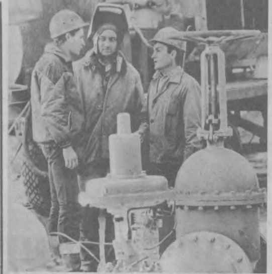
На две недели раньше срока завершили монтаж 7-го блока четвертой очереди Мубарекского газоперерабатывающего завода. В настоящее время ведутся пусконаладочные работы. На строительстве трудятся представители 30 национальностей. НА СНИИЭСХ (слева направо) монтажники Валерий Парамонов, специалист из Болгарии Ковачев Васил Ангелов и бригадир монтажников Рамс Зулкарнаев.
