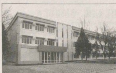
Реконструированное здание химико-металлургического факультета НГИИ.
