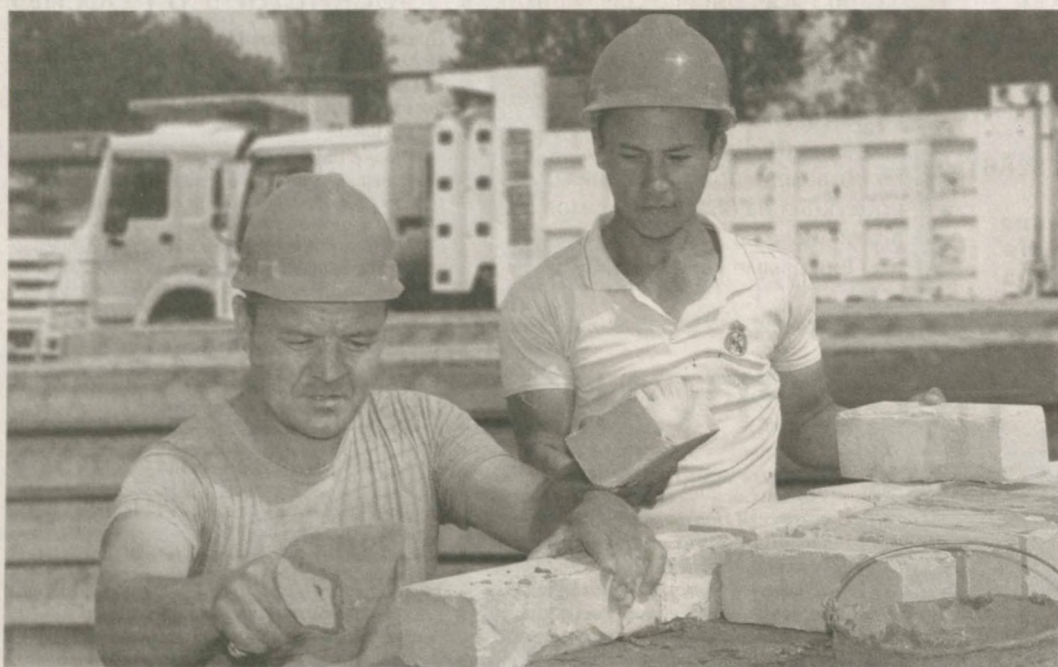
В Янгйюльском районе приступили к строительству современного двухэтажного здания общеобразовательной школы №10.
