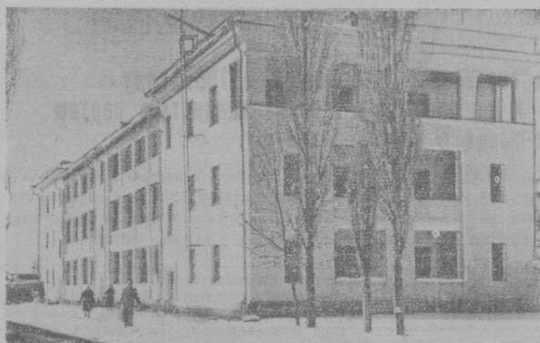
Коллектив завода «Чирчиксельмаш» решил в течение ближайших 2 — 3 лет полностью разрешить жилищную проблему. Здесь широко развернута работа по методу горьковчан. На снимке: новый жилой дом на 27 квартир для работников завода. Фото А. Палехова.
