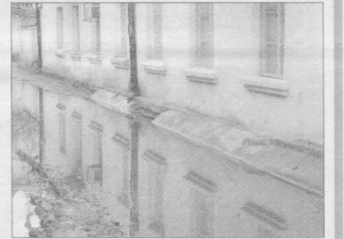
подъездах, лифтах, палисадниках, около гаражей. Но справиться с потоками воды на пешеходном тротуаре им не под силу. Кто же поможет нам? Лидия ПОПОВА.
