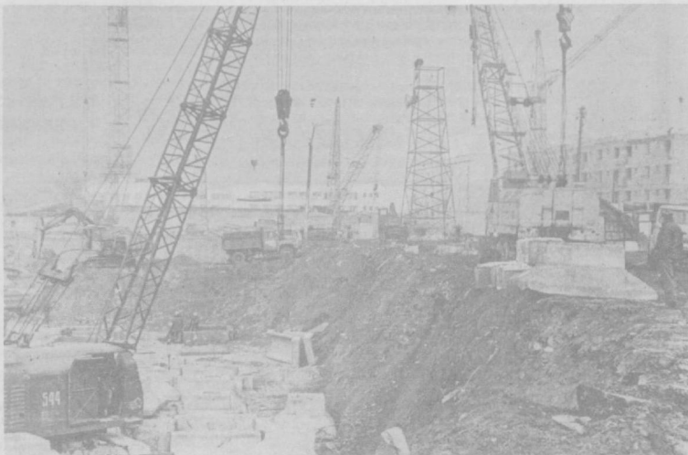
На строительных площадках
