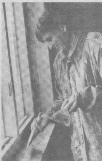
НА СНИМКАХ: бригадир монтажников И. Г. Похолкив; маляр Л. Любимченко; идет строительство; маляр Т. Агапова за работой.
